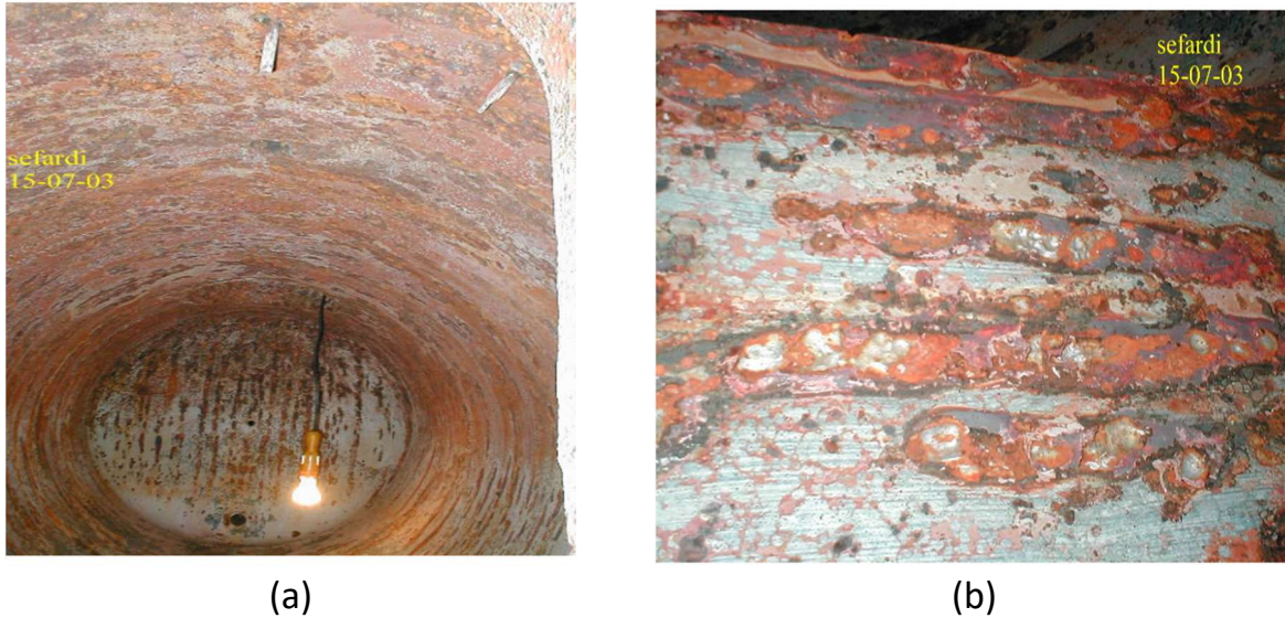
Figura 10 - Fotografia do interior de caldeira (a) Vista geral, (b) Detalhe das formações calcárias.
