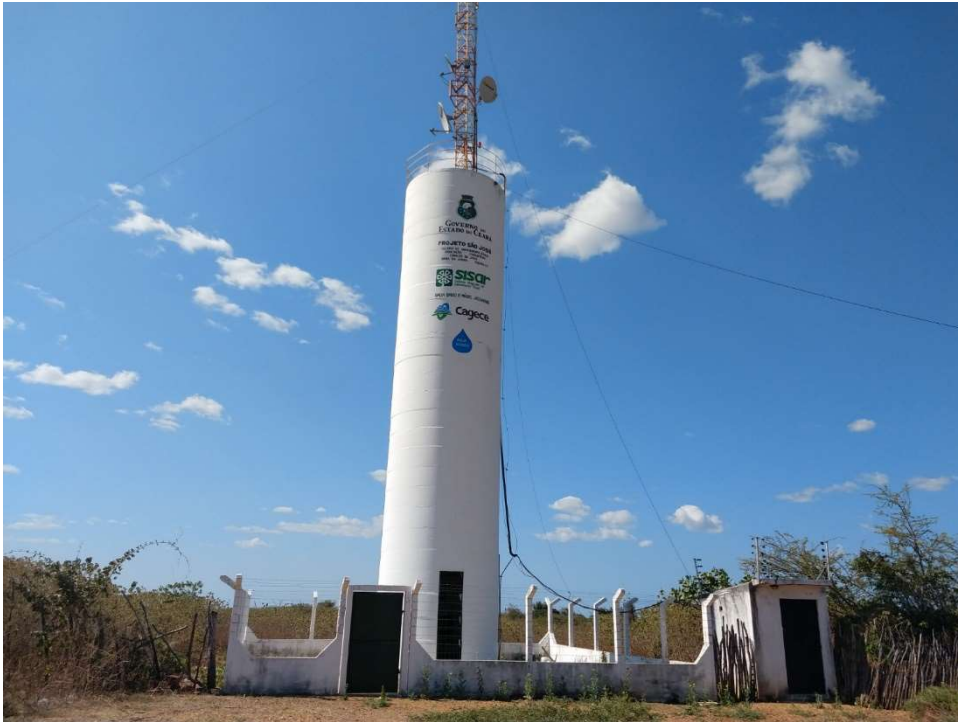
Figura 41 – Reservatório elevado do SAA
