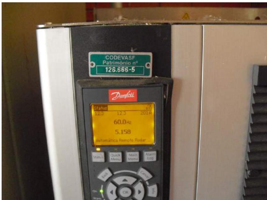
Figura 6.30 – Detalhe de um inversor de frequência instalado numa estação de bombeamento secundária do Perímetro de Irrigação Nilo Coelho - Brasil
