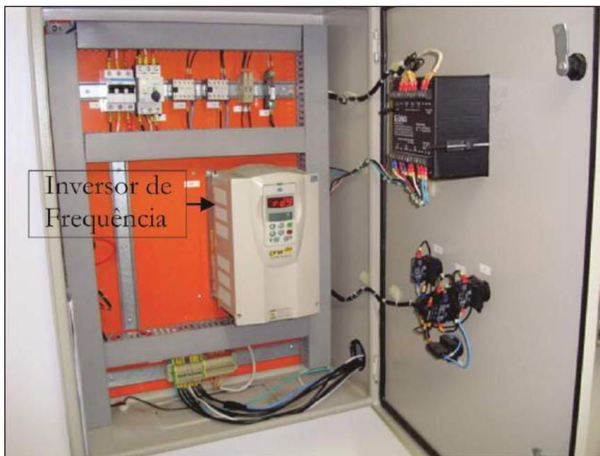
Figura 6.31 – Inversor de frequência instalado num quadro de comando de um conjunto motobomba do LENHS/UFPB – João Pessoa, Brasil
