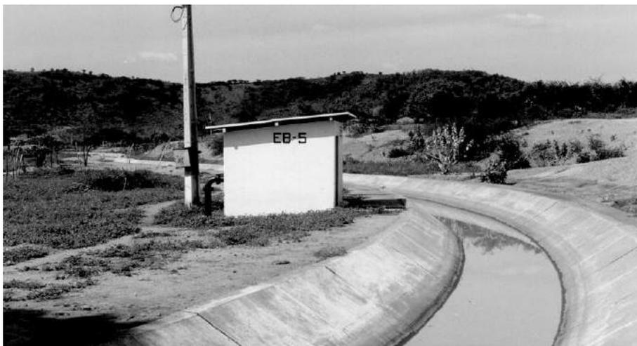
Figura 5.3 - Canal adutor e estação de bombeamento secundária do perímetro irrigado de Gravatá – Paraíba, Brasil
