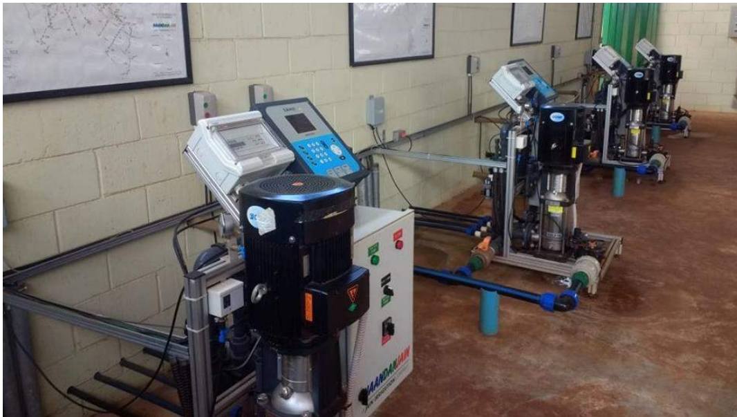
Figura 12. Central de controle e monitoramento da irrigação e fertirrigação totalmente automatizado e digitalizado, instalado em sistema de irrigação por gotejamento subsuperficial em cultura de cana-de-açúcar para alta produtividade e redução de custos de produção, em operação em empresa do setor sucroenergético no noroeste do estado de São Paulo.
